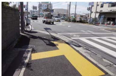
南花田町交差点付近
